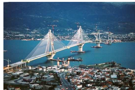
Le pont Rion-Antirion
